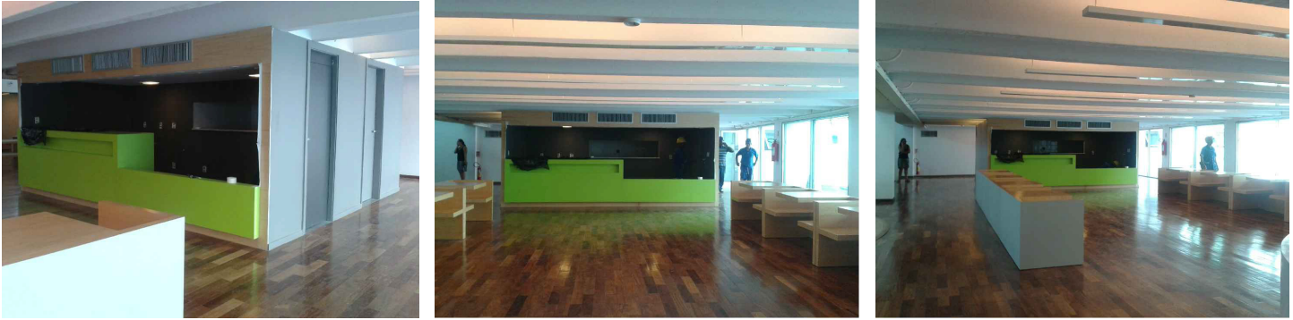
IMAGENS CAFÉ (EM CONCLUSÃO DE OBRA)
