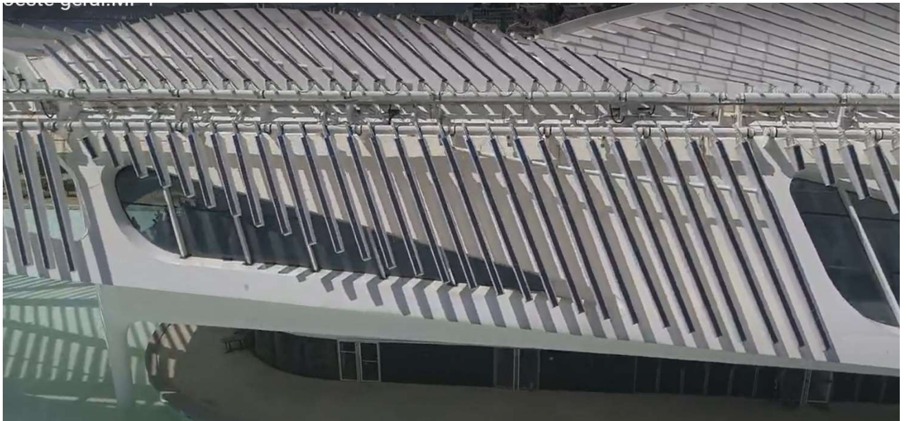
FOTO 51 – LATERAL OESTE ENTRE EIXOS G3 e G4
