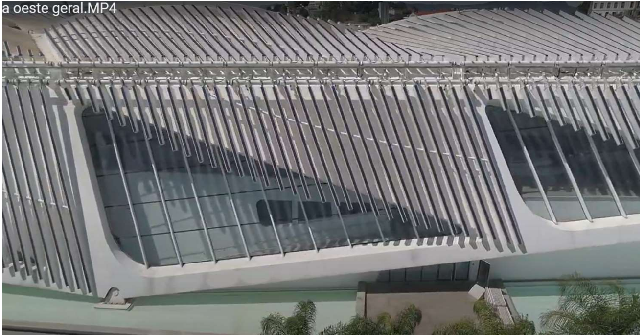
FOTO 47 – LATERAL OESTE ENTRE EIXOS G-2 e G-1
