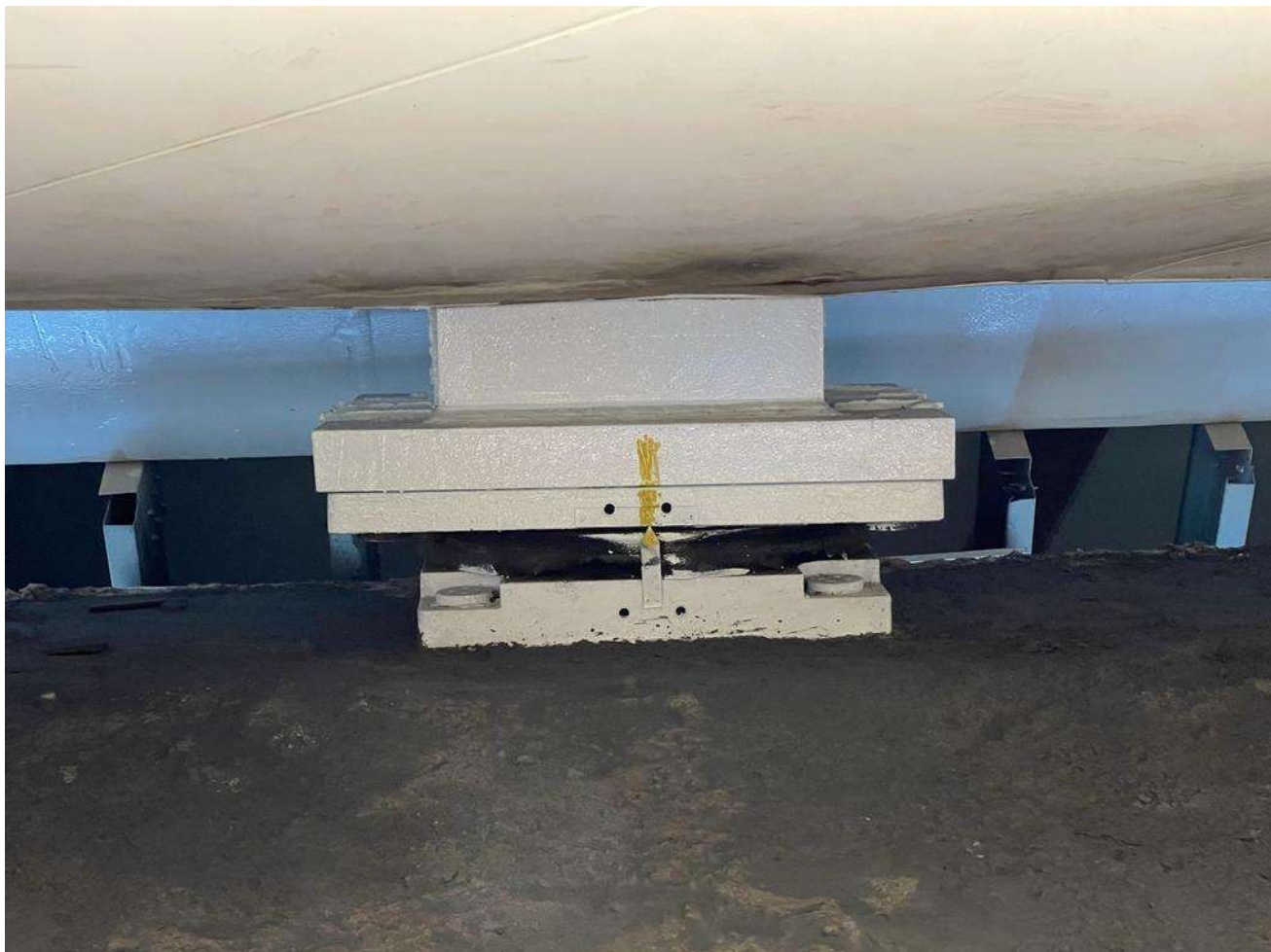
FOTO 04 – APARELO DE APOIO SUPERIOR*
