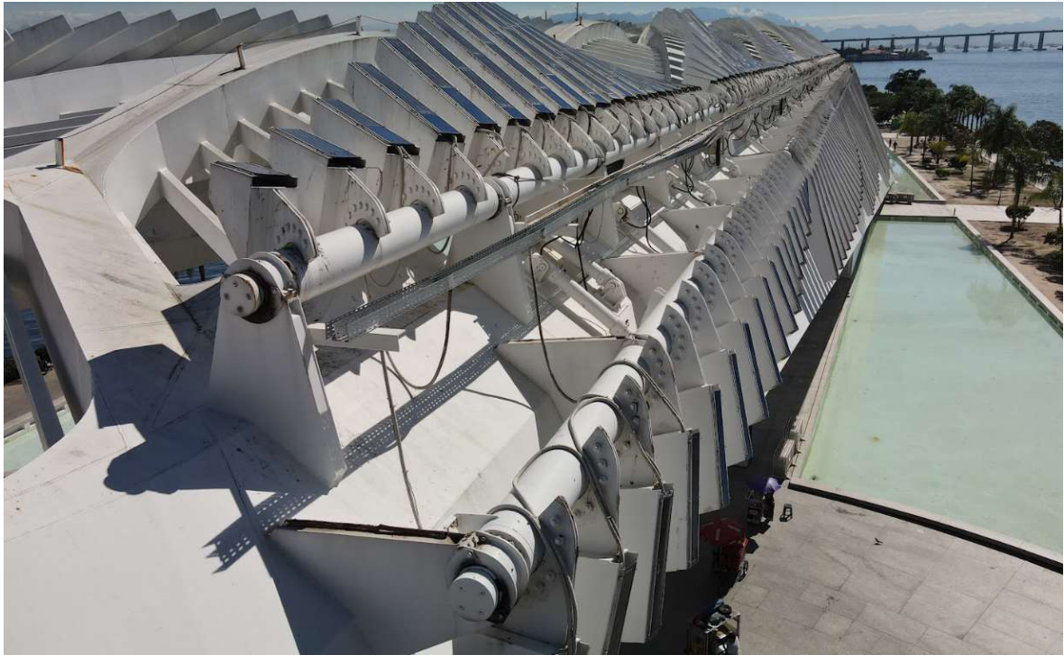
FOTO 63 – EIXOS DE MOVIMENTAÇÃO DAS ALETAS LESTE
