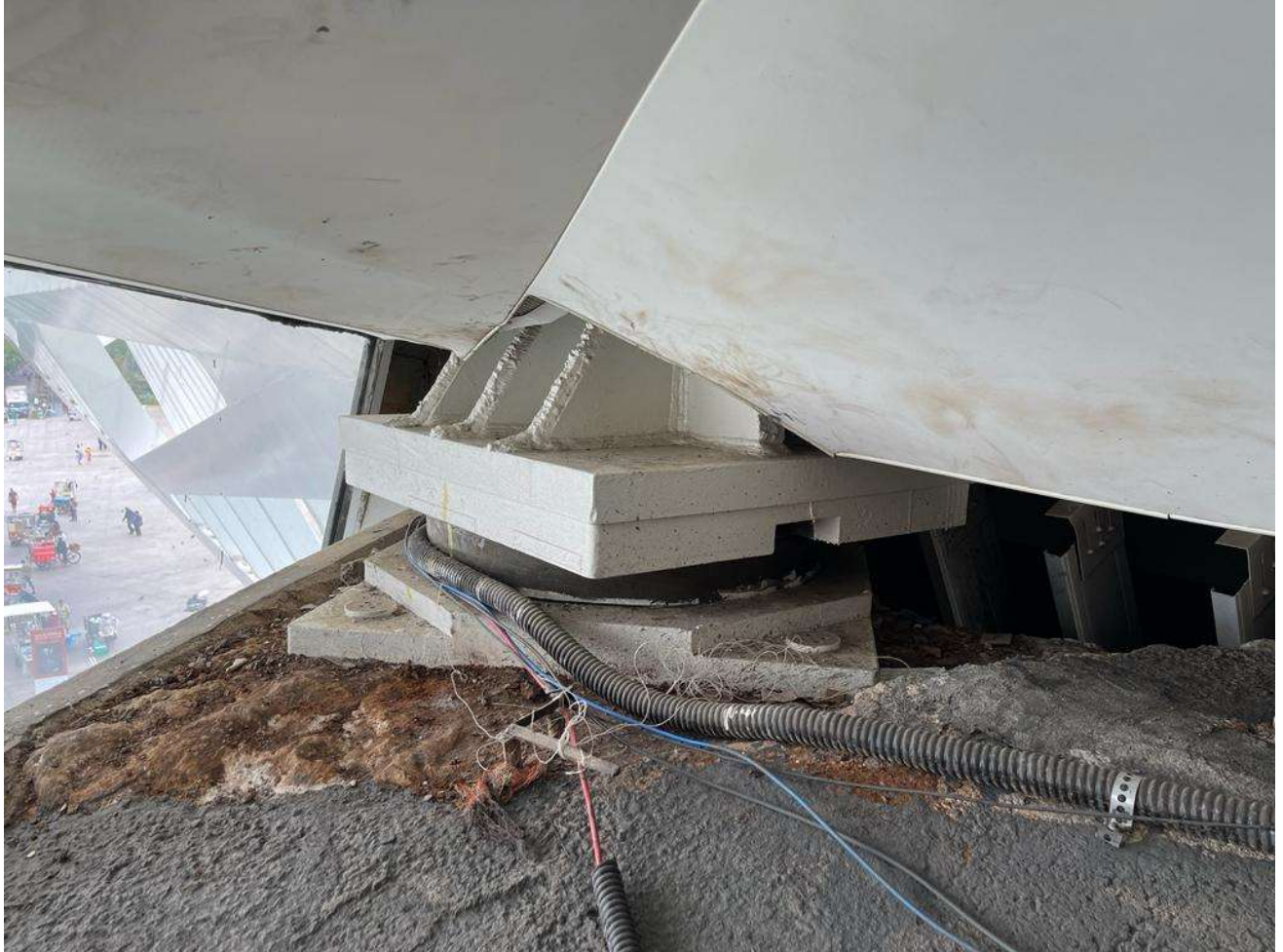
FOTO 02 – VISTA GERAL – BALANÇO TERRA APARELHOS DE APOIO
