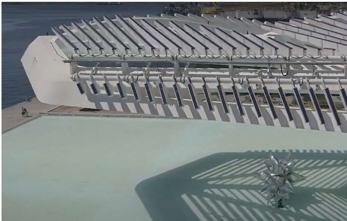
FOTO 54 – LATERAL OESTE ENTRE EIXOS G6 e G7
