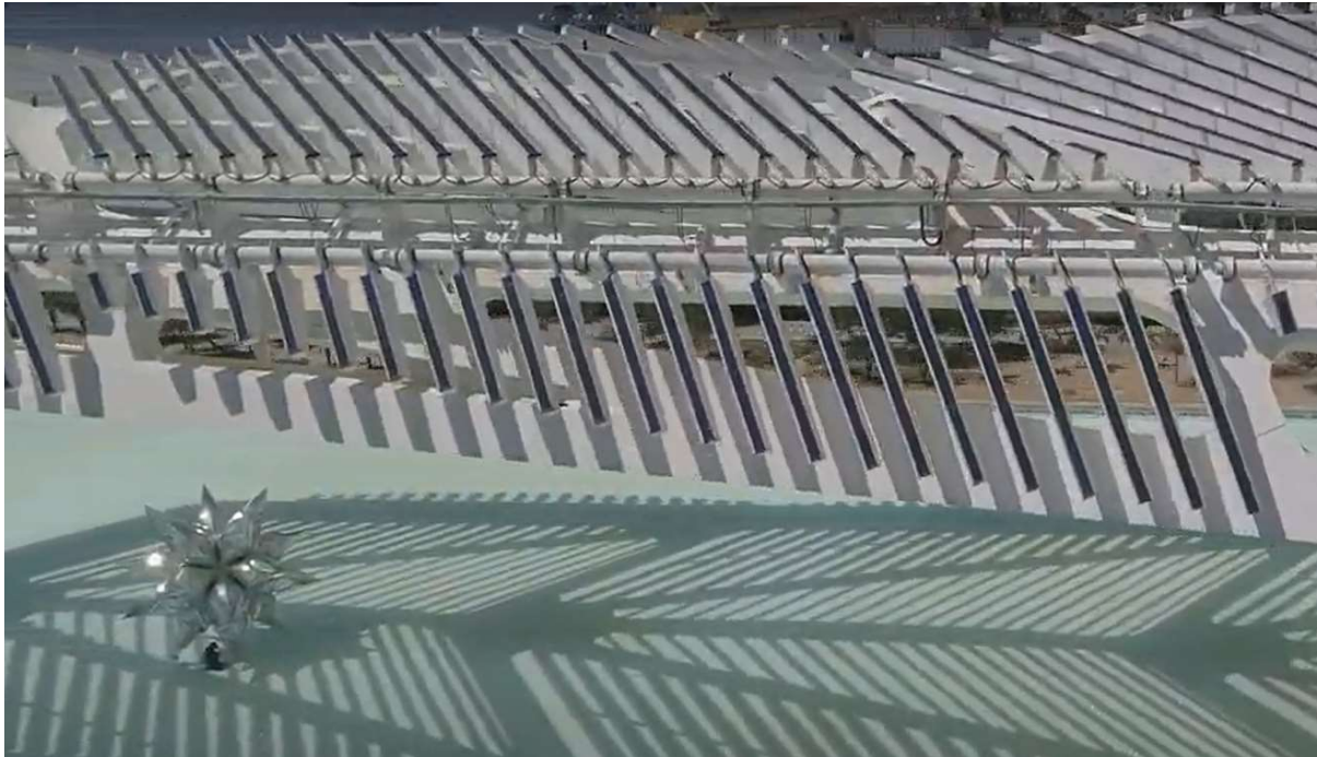
FOTO 53 – LATERAL OESTE ENTRE EIXOS G5 e G6
