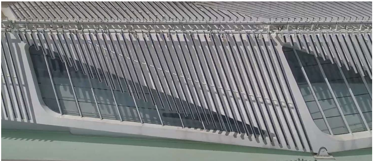
FOTO 48 – LATERAL OESTE ENTRE EIXOS G-1 e G1
