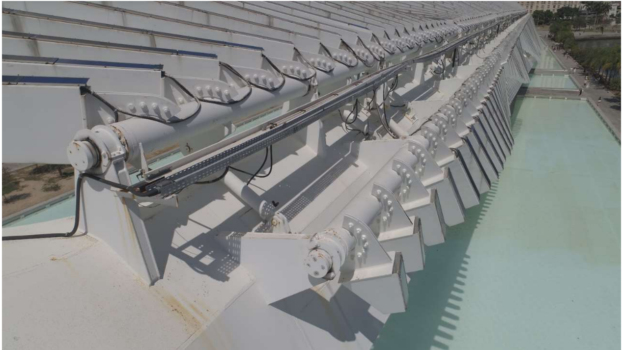
FOTO 61 – EIXOS DE MOVIMENTAÇÃO DAS ALETAS OESTE
