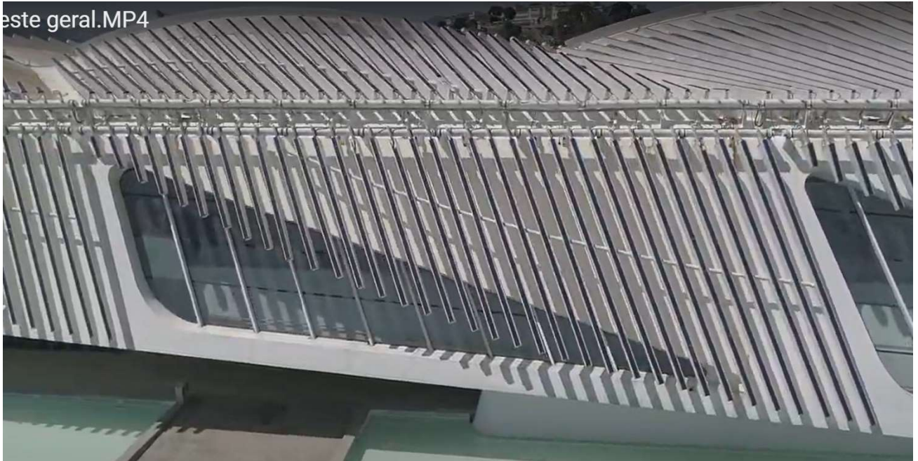
FOTO 49 – LATERAL OESTE ENTRE EIXOS G1 e G2
