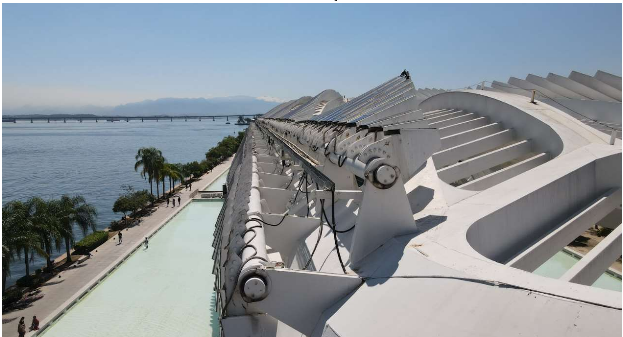
FOTO 62 – EIXOS DE MOVIMENTAÇÃO DAS ALETAS OESTE
