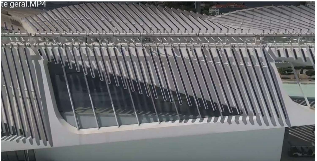
FOTO 46 – LATERAL OESTE ENTRE EIXOS G-3 e G-2
