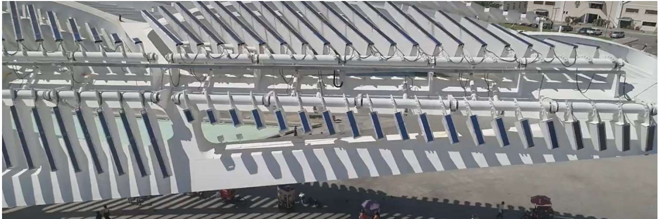
FOTO 43 – LATERAL OESTE ENTRE EIXOS G-6 e G-5
